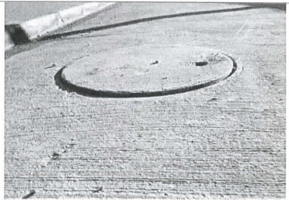
FOTO N° 14 TAPA CÁMARA A DESNIVEL
