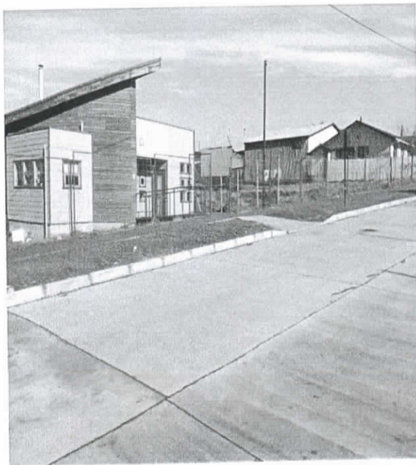
Foto N° 5 Centro Comunitario de Rehabilitación
