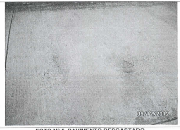
FOTO N° 5 PAVIMENTO DESGASTADO
