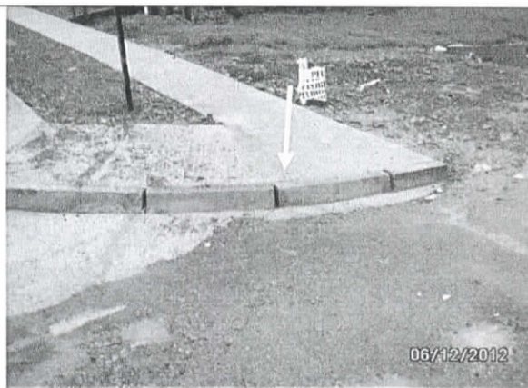
FOTO N° 2, SOLERAS SIN EMBOQUILLADO
