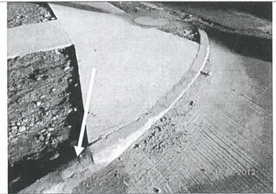
FOTO N° 9 DEFICIENTE EMPALME CON SOLERA
