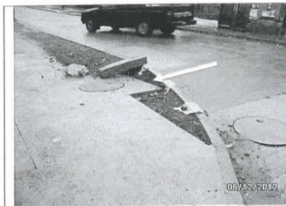
FOTO N° 10 ACERA A DESNIVEL CON SOLERAS
