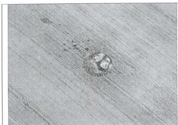
FOTO N° 26 TESTIGO MAL TAPADO
