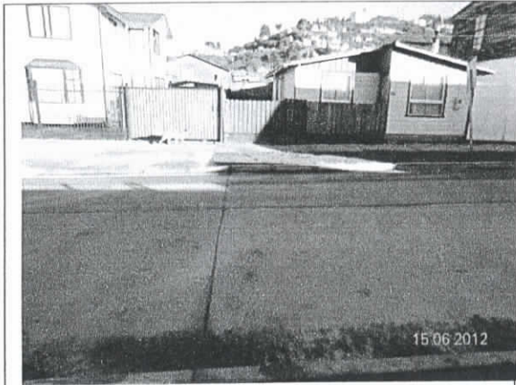
FOTO N° 6 PAVIMENTO DESGASTADO
