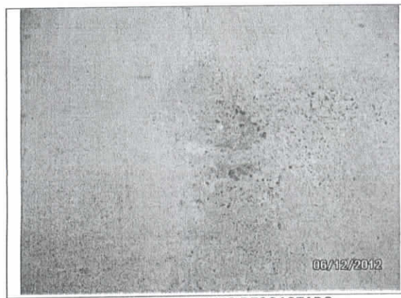
FOTO N° 4 PAVIMENTO DESGASTADO
